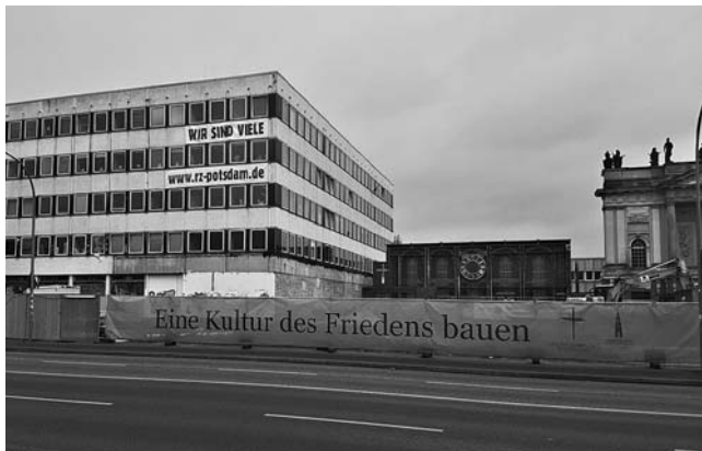
In enger Nachbarschaft: Rechenzentrum und Turmbaustelle
