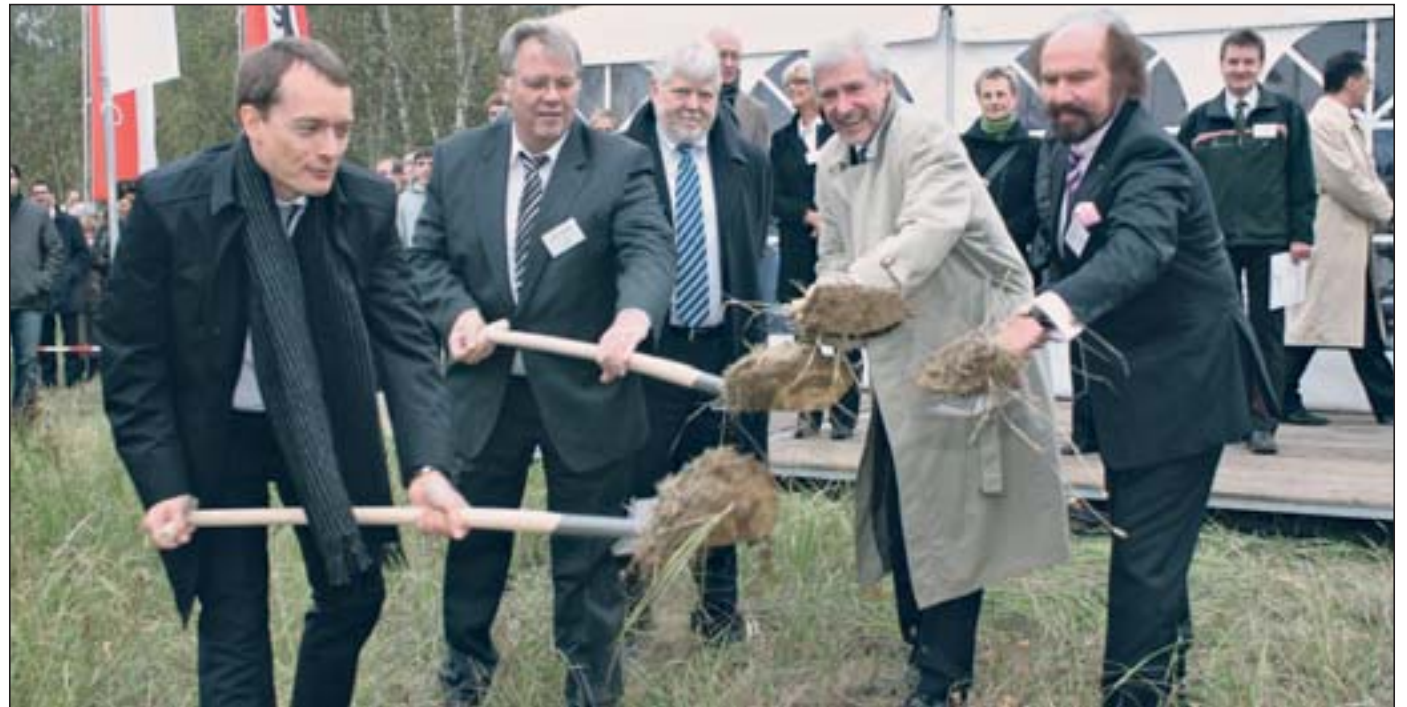
Eine angenehme Aufgabe für Peter Kaminski (z.v.l.) – der erste Spatenstich im Villenpark Groß Glienicke.
