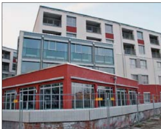
Das neue Seniorenzentrum an der Neustädter Havelbucht – ein Neubau in der Brandenburger Vorstadt.
