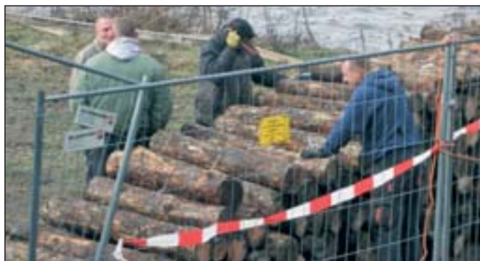
Eine „Mauer“ aus Stämmen wurde am 15. Januar errichtet.
