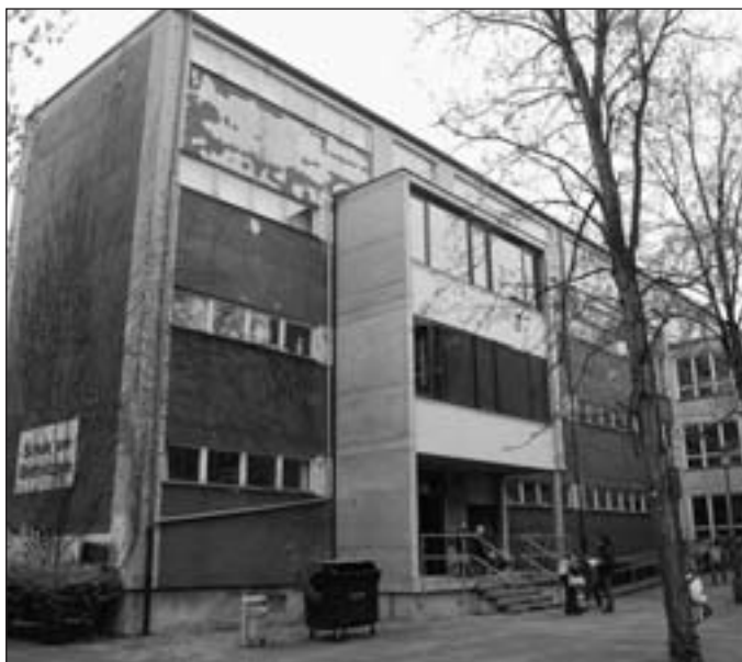
Die Sanierung der Grundschule am Griebnitzsee soll im Juli beginnen, jetzt sollen die Eltern endlich Bescheid bekommen, was auf sie zukommt.
